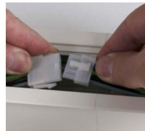
Enkelt att rampa systemarmaturerna; överkoppling med snabbkoppling mellan armaturerna.
