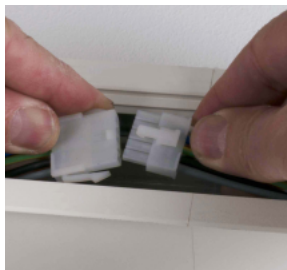
Enkelt att rampa systemarmaturerna; överkoppling med snabbkoppling mellan armaturerna.
