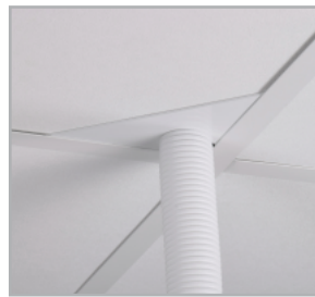
Slang med trekantig takgenomföring, för hörn.
