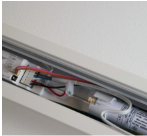
Inbyggd nödljusenhet. Vid leverans är batteriet ej anslutet.
