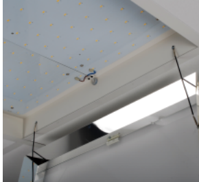
Ramen till Lavanda är fällbar och kvarhängande.
