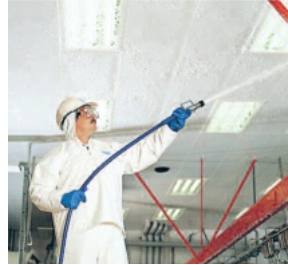
Ecolux Lavanda kan tvättas effektivt med rengöringsmedel och högtryckstvätt.
