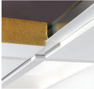
Casella Delta 4162A monterad i modulundertak kant E – under T-profilen
